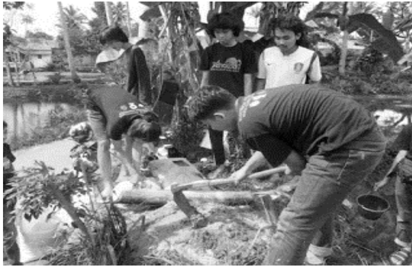
Gambar 5. Penggalian tiang solar panel
