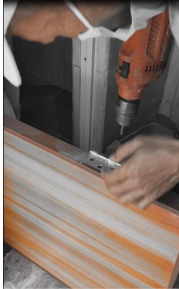
Gambar 13. Proses memasang engsel pada daun pintu panel beton ringan
