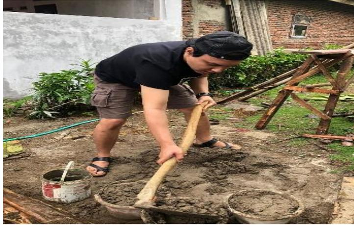
Gambar 4. Proses adukan untuk pondasi lampu jalan
