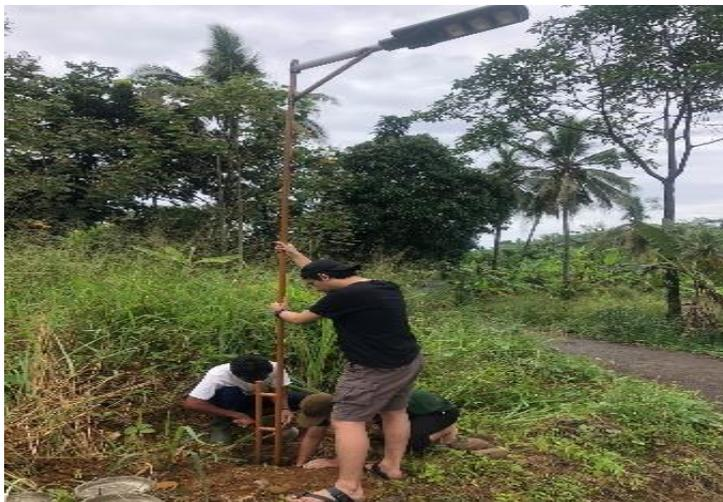
Gambar 5. Proses pemasangan lampu solar cell
