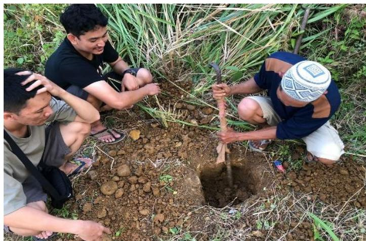
Gambar 3. Proses pembuatan pondasi lampu
