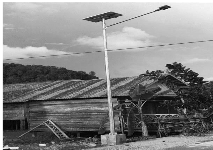
Gambar 8 Hasil Pemasangan lokasi 2
