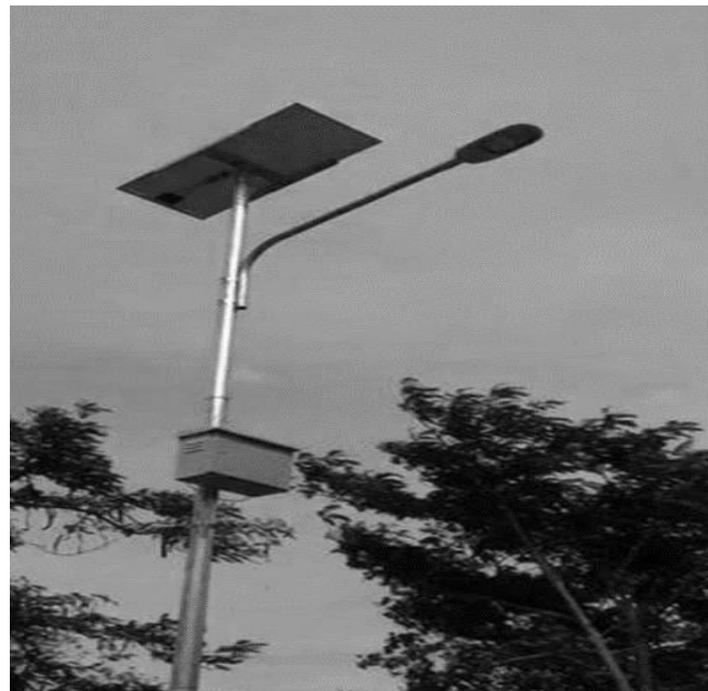
Gambar 9 Hasil Pemasangan lokasi 3
