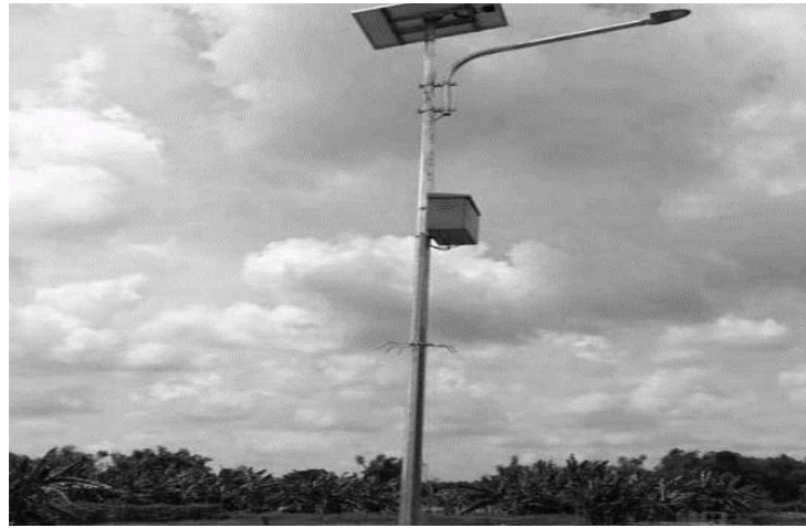
Gambar 7. Hasil pemasangan lokasi 1
